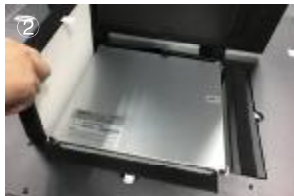
2、将新风端高效滤网沿导轨垂直向上抽出
