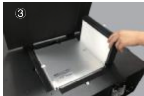
3、将新风端中效滤网沿导轨垂直向上抽出
