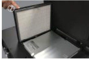
7、更换新风端高效滤网 将新的高效滤网按照滤网标签指示方向安装至原位
