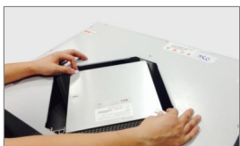
④ 更换全热交换芯，将清理后的 全热交换芯安装至原位
