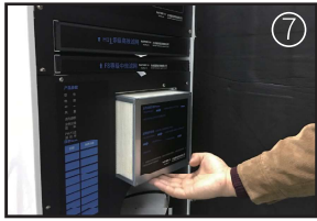
⑦ 将全热交换芯体安装至原位
