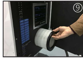
⑨ 将新风端初效滤网安装至原位
