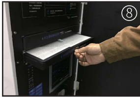
⑧ 将新风端中高效滤网安装至原位
