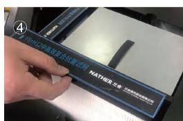
4、更换新风端滤网,将新的中高效复合抗菌滤网按照滤网标签指示方向安装至原位
