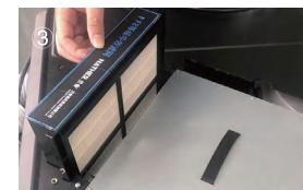
3、将排风端中效滤网沿导轨垂直抽出
