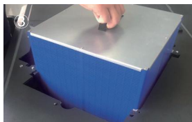
3、将高效全热交换芯沿导轨垂直方向取出
