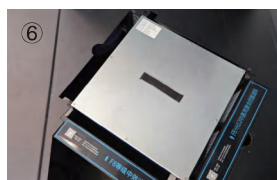
6、将清洗后的高效全热交换芯安装至原位，并固定好
