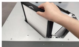
④ 更换排风端中效滤网 将新的中效滤网安装至原位， 请保持滤网箭头标贴方向与 排风进风方向一致
