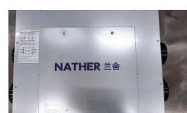
⑥ 将检修面板复原，安装回 原处，并固定好
